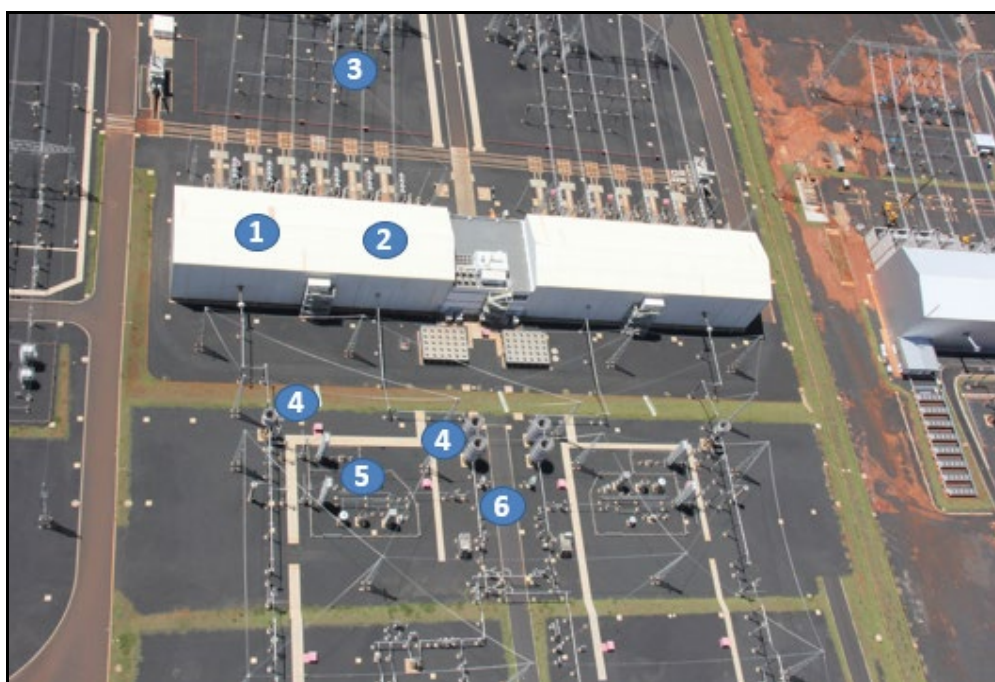
Figura 2 - Disposição dos equipamentos
